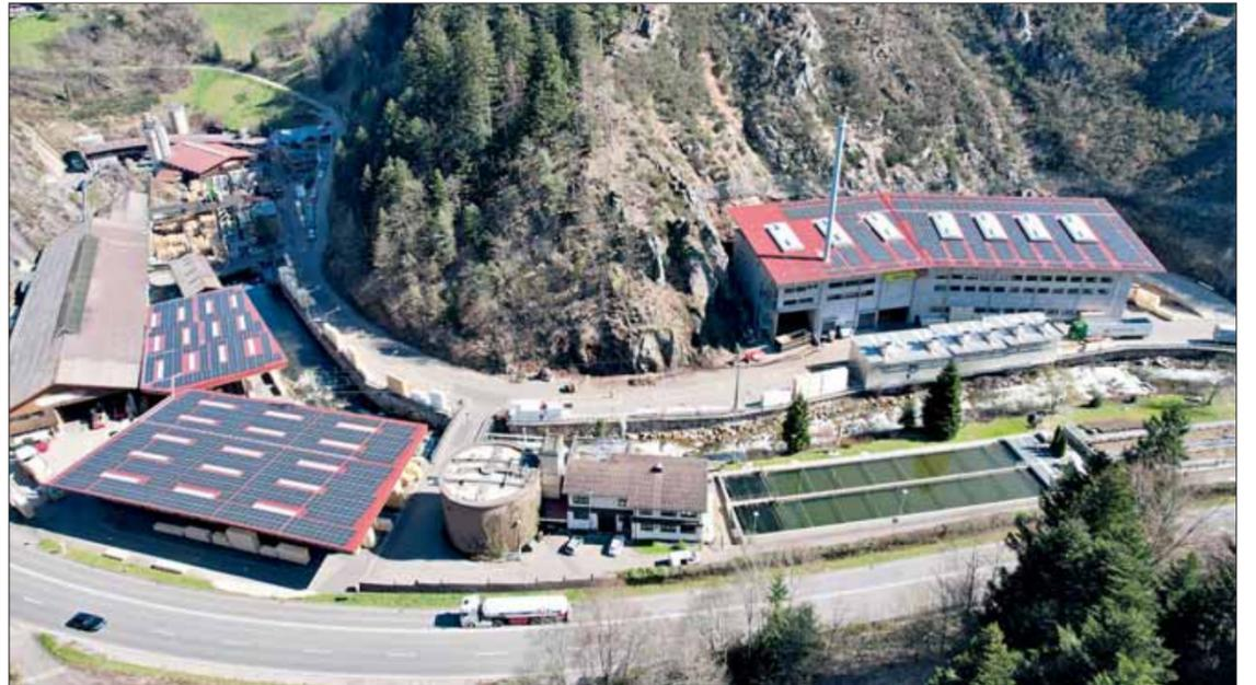
Das Sägewerk Finkbeiner in Triberg im Schwarzwald steigerte seine Eigenstromversorgung Ende 2022 mit einer Photovoltaikanlage auf rund 70 %.
